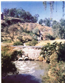
Figura 7.4. En caso de vías terrestres, la intervención del topógrafo es necesaria para determinar las pendientes de las curvas.
