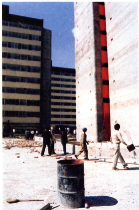
Figura 7.26. Daños causados por explosión, caso 1
