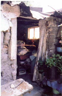
B. Entrada de la vivienda hecha de mampostería y puertas a base de cortinas.
