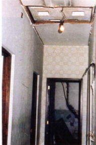
Figura 7.2. Desmantelamiento de instalaciones
