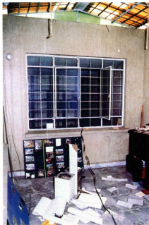
B. Vista general de la cochera en desorden.
