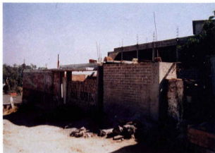
Figura 7.7. Límites y colindancia entre terrenos en construcción.
