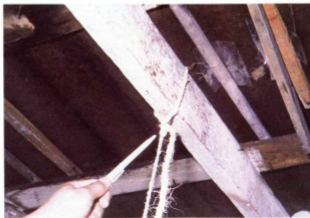
E. En la parte alta de la vivienda se observa una viga de 10 \times 5 cm, de la cual pende un laxo de henoquin anudado por medio de tres nudos simples.
